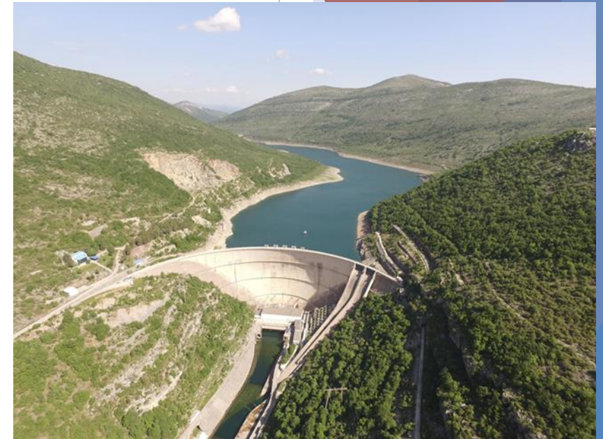
Хидроелектрана Требиње I
